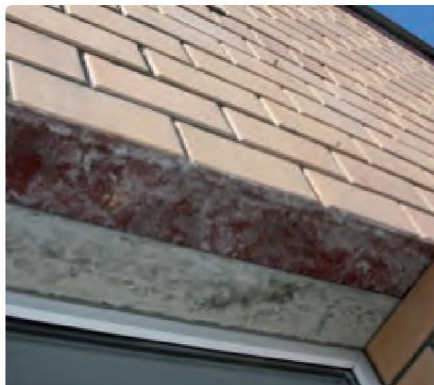
Внешний вид кладки без применения перемычек ЛСР
