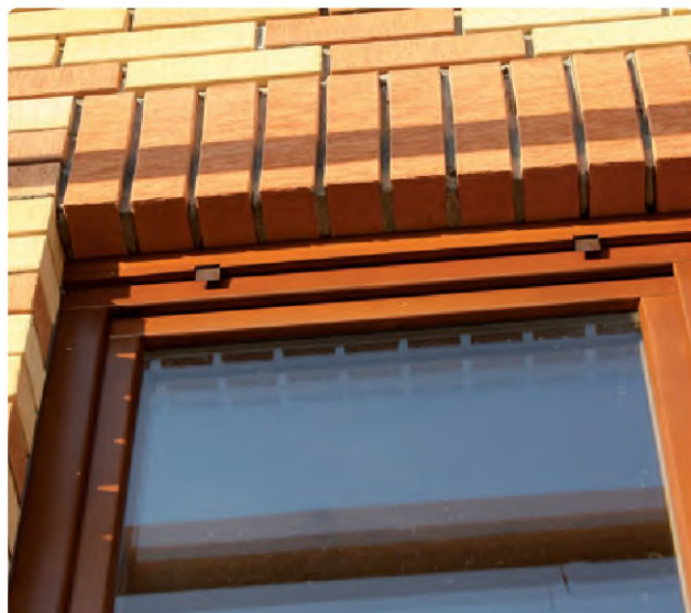
Внешний вид кладки с использованием перемычек ЛСР
